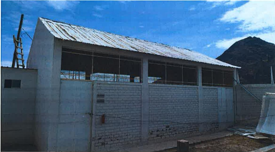
*Imagen 2 Salón principal de albañilería con techo de calamina*
